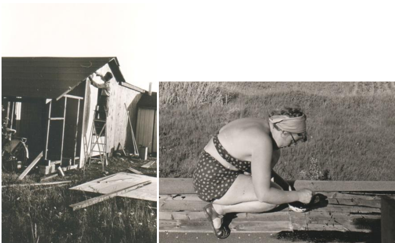
Far och mor vid bygget av sommarstugan.
